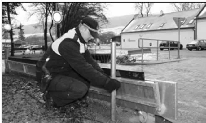
Strážník David Svoboda kontroluje funkčnost protipovodňové zábrany v Primátorské ulici. Foto Václav Malina
